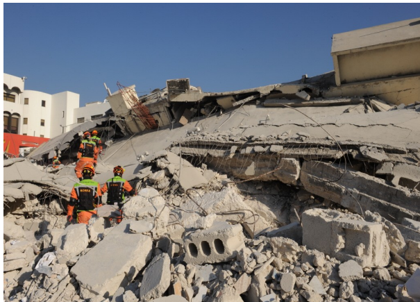
[그림 4-2] 아이티 지진 건물붕괴 현장
