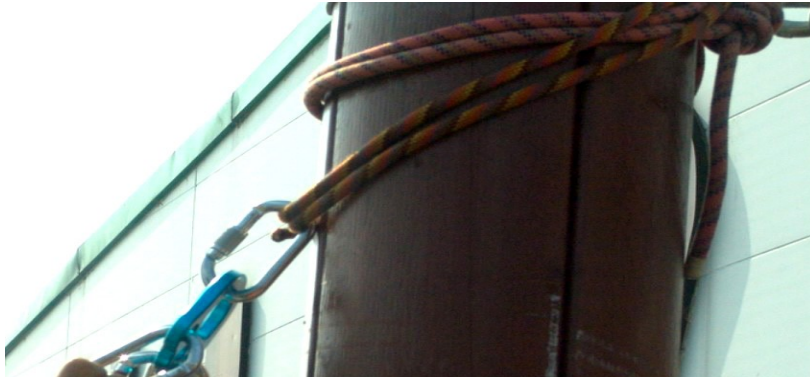
[ 그림 3-204 ] 확보로프 설치
