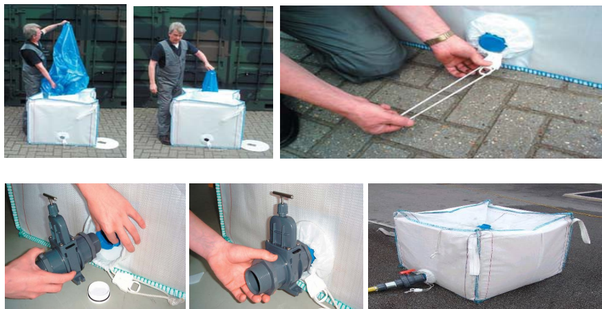
[ 그림 5-123 ] 급수(폐수)탱크 조립
