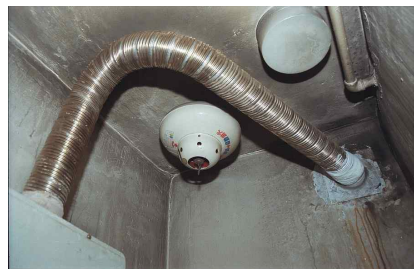
[ 그림 1-57 ] 배기통 설치 불량
