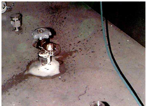
[ 그림 1-29 ] 기밀이 유지되지 않는 밸브
