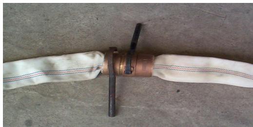
[호스 개폐기(Spanner)를 이용한 소방호스 연결모습]
