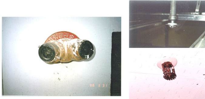
[스프링클러 송수관 및 헤드의 설치 예]
