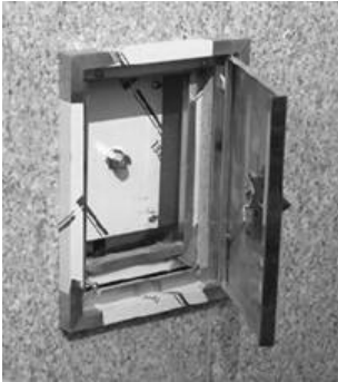
[그림 3-21] 무선기 접속단자함 및 분배기
