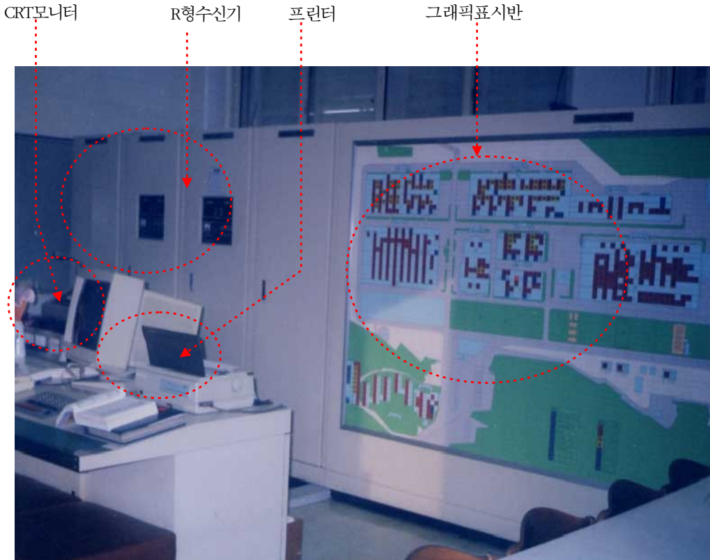
[그림 2-60] R형 시스템으로 구성된 방재센터
