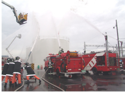
(그림 5.17) 무인대량 방수장비는 탱크를 냉각시키는 데 사용한다.
