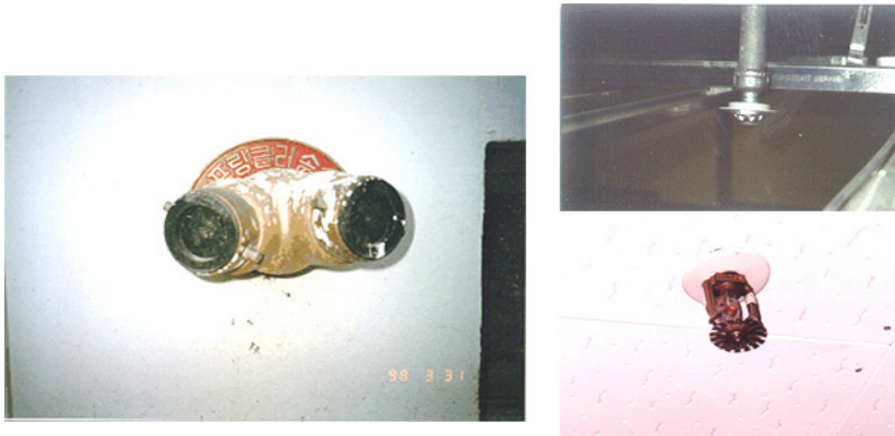
(스프링클러 송수관 및 헤드의 설치 예)
